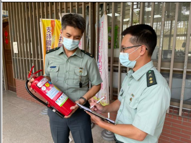
檢查滅火器材是否定期更換、氣壓是否充足
