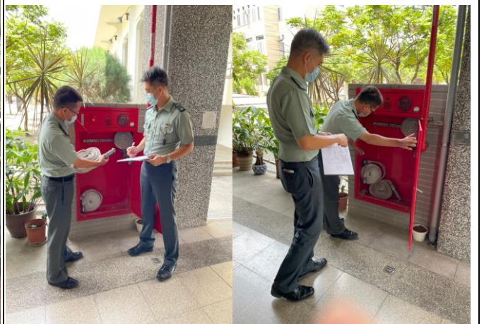
檢查消防栓是否正常
