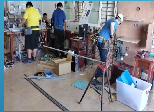
機整+室配+工配三合一模擬訓練
