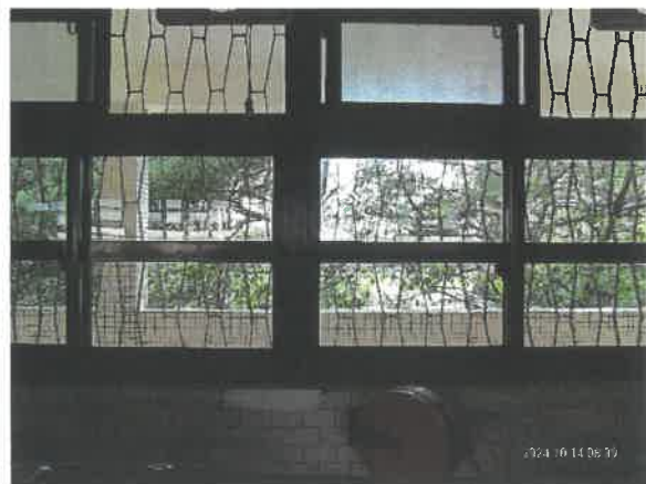
圖 1 更新後由工場內看向走廊
